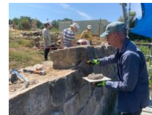
Travaux de maçonnerie (rebouchage de la contrescarpe) et sondages du château
